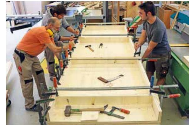
6. Der insgesamt 14 Meter lange Sockel wird aus fünf Einzelteilen hergestellt.
